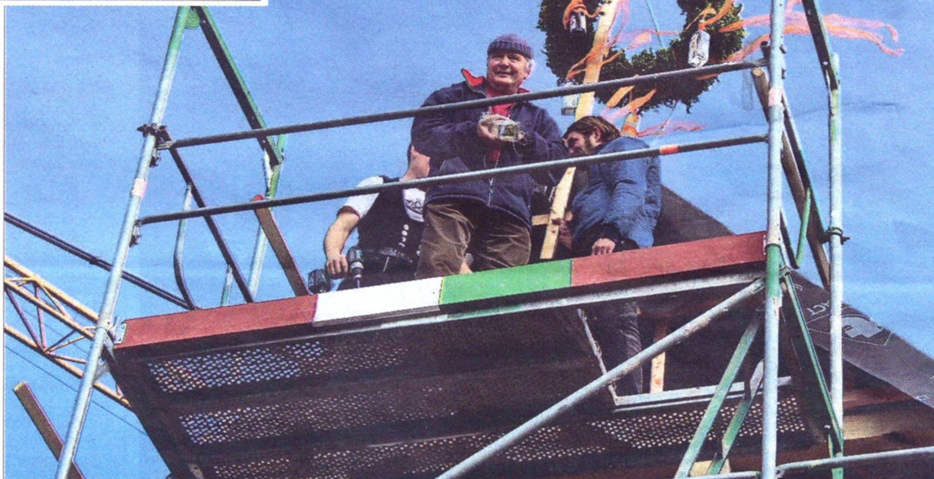
Der Stiftungsvorsitzende Bernd Hildebrandt (großes Bild, Mitte) versorgt die durstigen Handwerker, die den Richtkranz gesetzt haben. Die beiden Fachwerkbauten (kleines Bild) sollen ab dem nächsten Jahr für die Reittherapie und als Unterkunft dienen. Sokoll (2)
